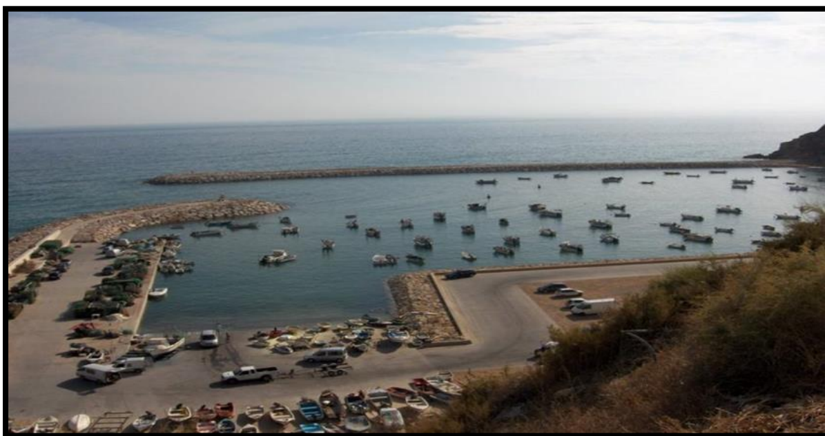
Figura 6 – Porto de Abrigo de Albufeira.
